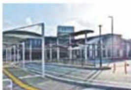
JR西条駅北口もきれいに整備。自由通路開通で、より賑わいを見せそう。
