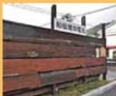
舟の舟板を家の外壁に利用した舟板壁。他所では見られない珍しいもの。
