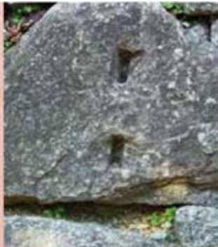
石垣の穴は、石を割る際に模を打ち込んだ跡と知る。
