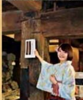
祈禱札が掛けられていたという、地階のメインの柱の1本。
