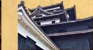
狭間は蓋付で外からわかりにくくなっている。急に銃口が突き出て狙い撃ちされたら逃げられないだろうと感じる。
