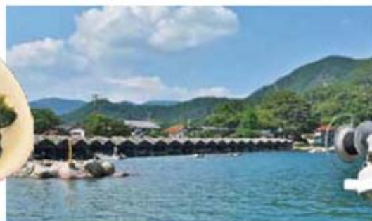
海岸線に松林と杉皮葺きの船のアパートが並ぶ舟小屋群。昔ながらの隠岐の漁村風景を残す。人にはまさに天国。
