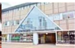
改装工事が終わり、すっきりリニューアルした JR 下関駅前。
