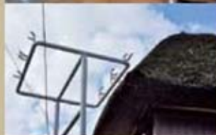
屋根の横にあるパイプ状の構造物は、スプリンクラーのような防火設備。
