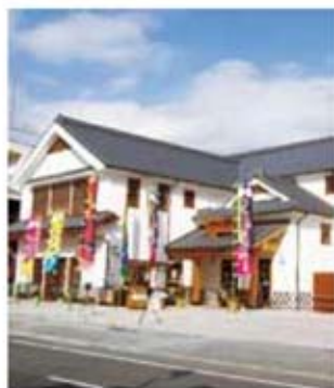
江戸大衆娯楽を現代に伝えるきつぎ衆楽館。随展示のほか、食事処や土産品店も常設。
