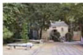
旧高島砲台火薬庫(国登録有形文化財)明治35年、陸軍が建設した高島砲台を移築復元。
