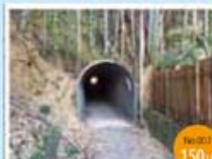
軍用連絡トンネル
