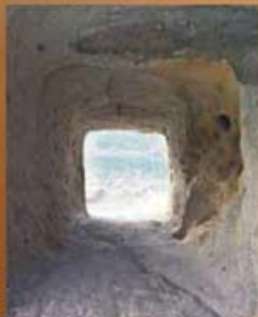
海辺を安全に通行する ため、人の手でくり抜 かれた樫浦トンネル。 手彫りの跡が残る。
