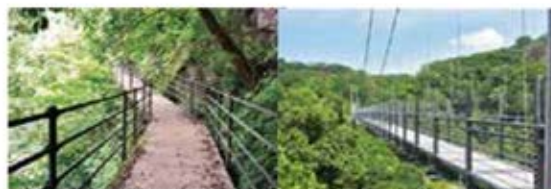
2013年に高さ45m・長さ160mの「舌震」恋・吊り橋」とバリアフリー遊歩道が全開通し、誰もが訪れやすくなった。
