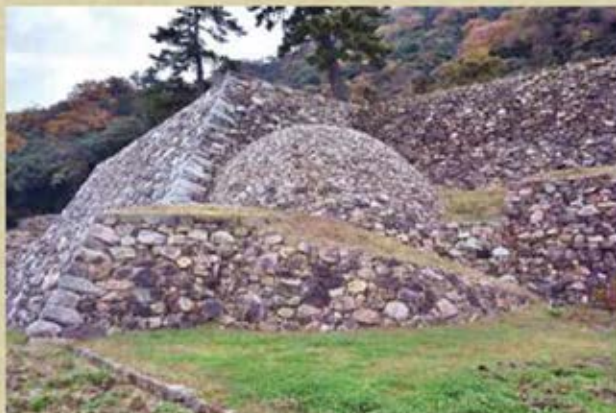
一目見て驚かされるのは、復元された天球丸の巻石垣。1804年頃に背後の石垣が崩れ、その崩落を防止するために築かれたという他に類を見ない球面の石垣。
