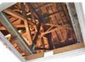
多角形に梁を突き上げる形に組むとき、中央でその束（か）など、高度な技術の小屋組みを見ることができる。
