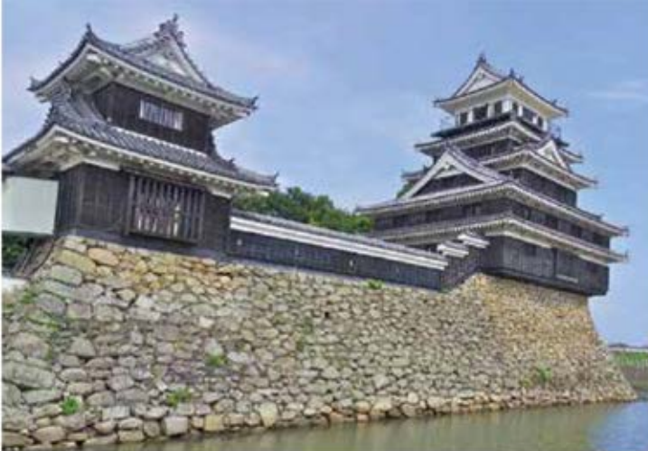
中津城の歴史を語る見どころの一つ、北側の堀に見られる黒田時代(右)と細川時代(左)の石垣の壁ぎ目。
