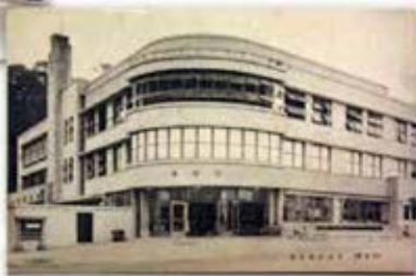
アールの壁が印象的な旧呉海軍下士官兵集会所は現在活用方法を検討中。上陸した水兵の宿泊施設だった。
