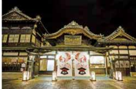
営業しながらの保存修理工事に着手した道後温泉本館。休憩室がある2階以上は休館しているが、1階神の湯で入浴可能。
