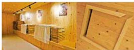
厳重な温度・湿度管理を要する製麹室も体験。温度管理に用いられる天井孔も再現しており、昔の建築の知恵と技に感心する。
